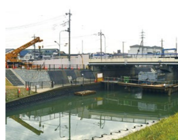
▲耐震補強工事中の山宮橋
