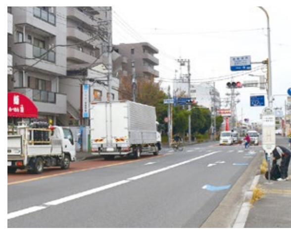
▲地下に雨水貯留管が設置される予定の北大通り
